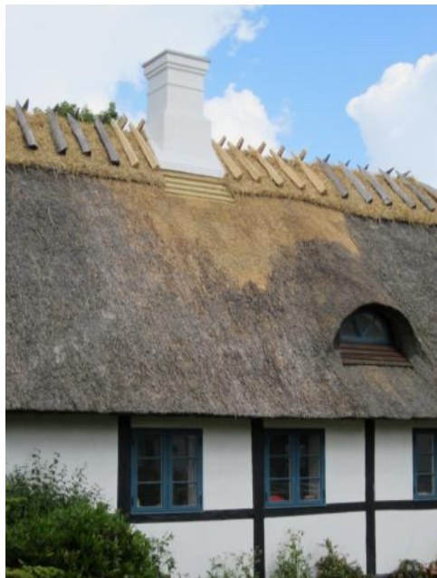
Den flotte, nye skorsten med nyt tækket træ omkring, Ballevej 1
