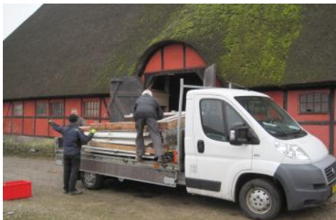
Nedrivningsmaterialerne læsses af ved Beldringe
