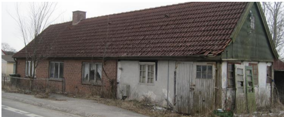
Forslag til nedrivning, Mønvej 106, i Ammendrup. Foto: KMO, marts 2013
