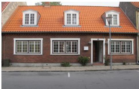
Adelgade 75—før, foto KMO, feb. 2013
